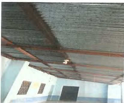
Foto 3. Cubierta de lámina
